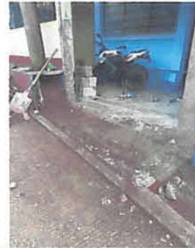
foto 4: sustitucion de porton
