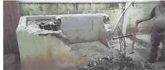
foto 10: demolicion de pileta existente
