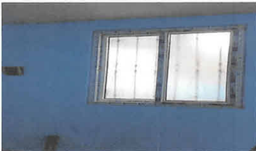
Foto 5: Inicio de instalación de ventanas
