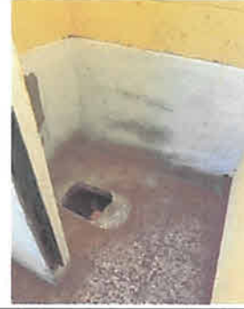
foto 2: sustitucion de baños y lava manos
