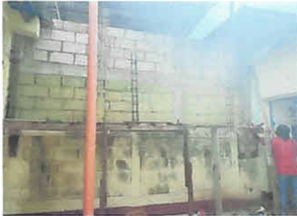
foto 9: muro de mamposteria en patio de juegos
