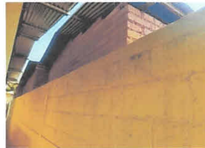
foto 6: suministro de raizon de seguridad
