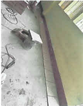
foto 3: sustitucion de piso ceramico modulo 2
